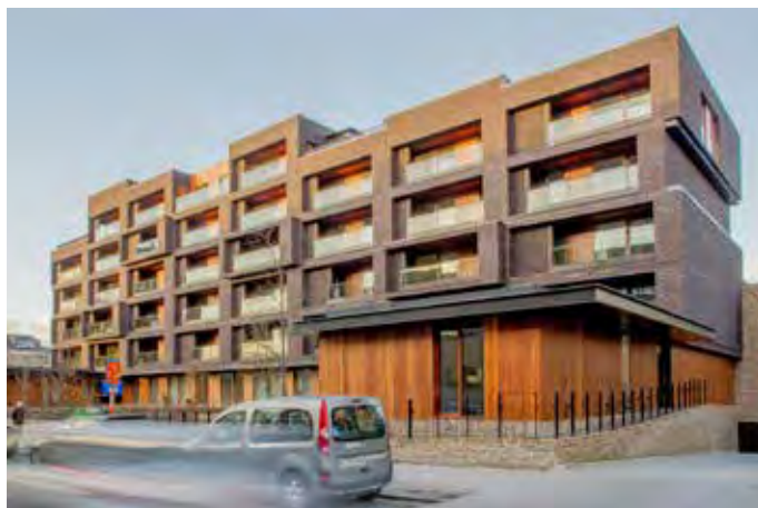
Clarenhof Woonzorgcentrum - Belgia - Mini Canal
