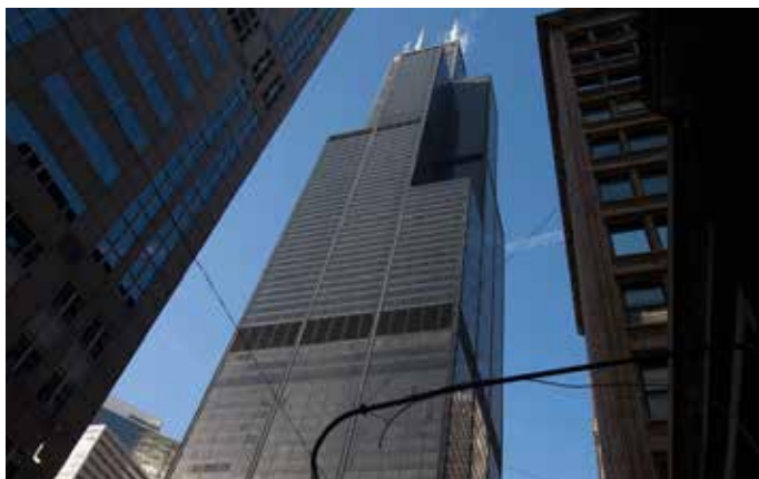
Willis Tower - USA - Clima Canal
