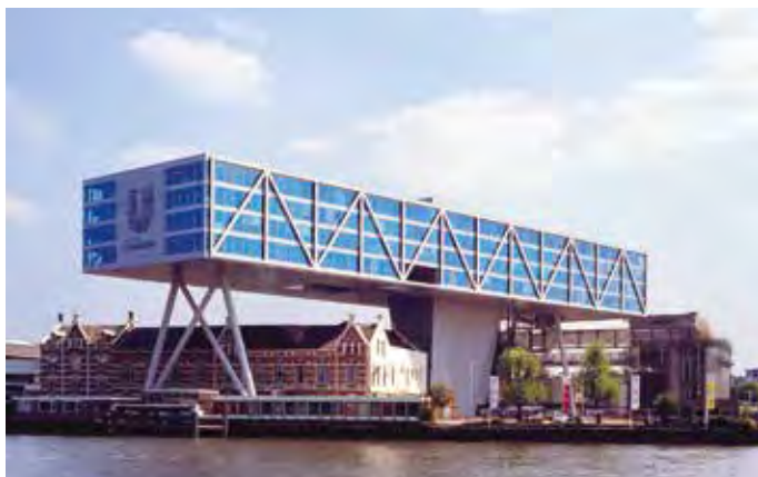
The Bridge Rotterdam - Holandia - Mini Canal
