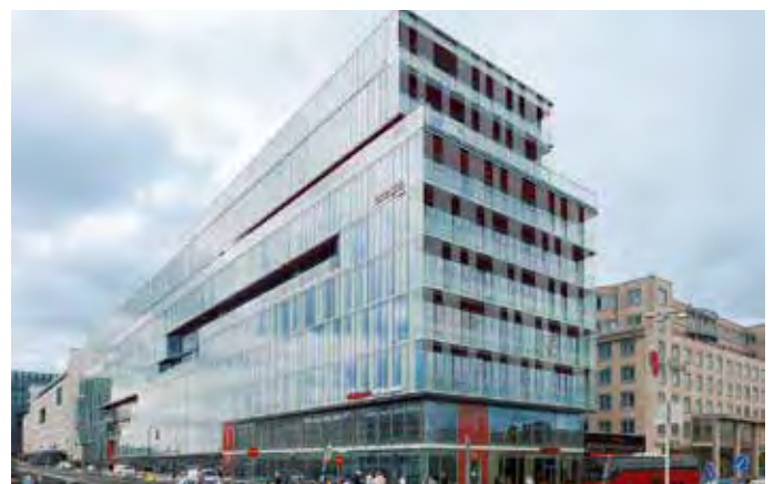
Kungsbrohuset - Szwecja - Mini - Strada
